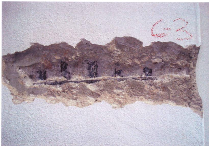
**Fotografía nº 3:** Vista de la CATA 3, realizada en la cara inferior de una viga inclinada interior.
