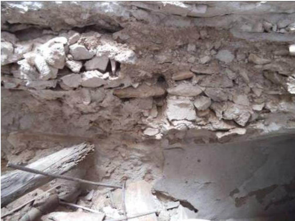
En la sección de bóveda hacia el otro lado, se ve perfectamente la primera capa que fue colocada un ladrillo, con mortero de cal y arena, unos ladrillos haciendo primera pasada sobre tablero o cimbras con mortero de cal y arena. 28/06/2016
