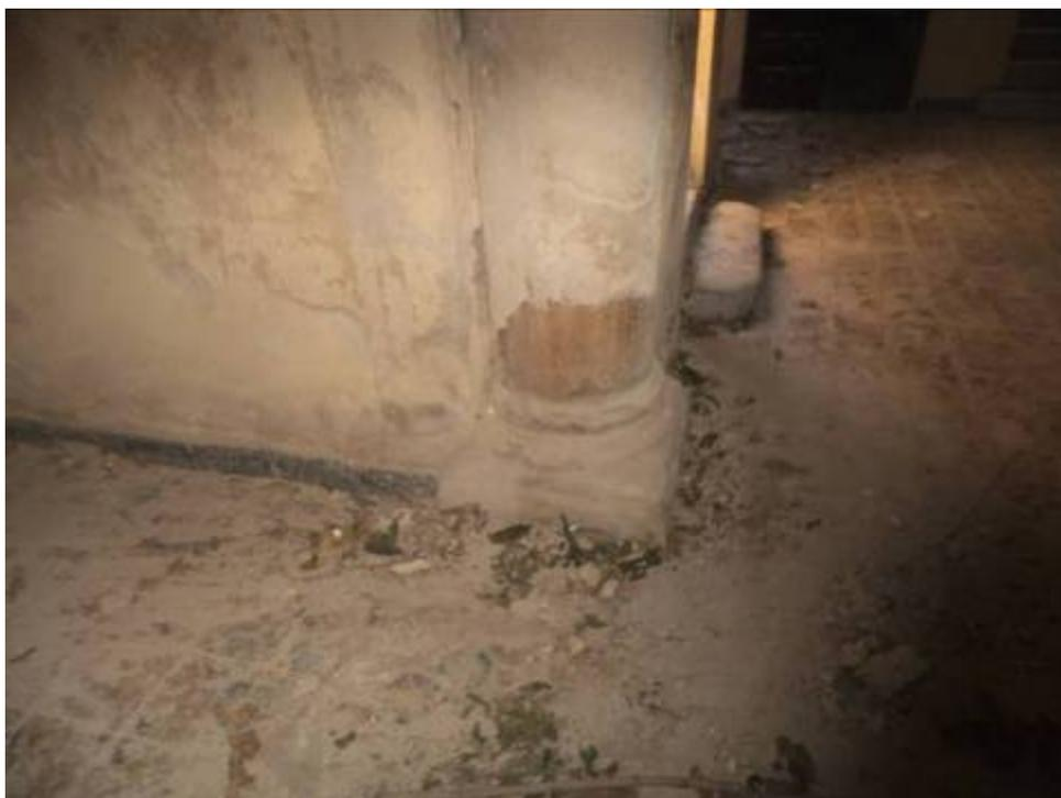
Las tres fachadas del patio que están en contacto con el corredor del porche, se cierran con tabicón a base de mampostería y mortero de cal en su parte interior y exterior, siendo el zócalo hasta 1,00 m enlucido y bruñido con mortero de cemento, por lo que podría ser de principio del Siglo XX.
