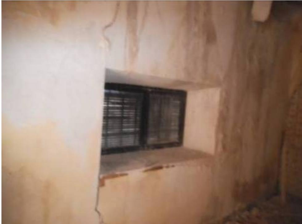
Los tabiques están realizados mediante entramado de madera que forman los huecos de paso e incluso con dimensiones que penetran en los muros de carga, manteniendo fijo el tabique de mortero de cal y ripio.
