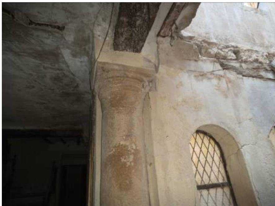
La base de 62x62 cm (3x3 palmos) de máximo contacto con el terreno y 33 cm de altura con arranque cuadrado, con sucesivas molduras, como escocías forman la base, dando paso al fuste que se compone de dos piezas, una de 1,045 m (5 palmos), y la parte inferior con diámetro de 2 palmos (41,795 cm), y de 62 cm de altura la piedra superior de fuste con 1 vara o 4 palmos castellanos.
