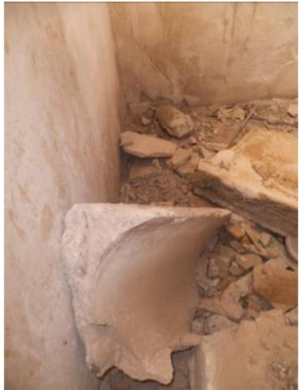
Formación de “bovedilla” entre vigas, mediante mortero de cal sobre formero, y capa de restos de teja y aljezones o ripios, que junto con la cal forma capa de compresión que transmite los esfuerzos o carga a las vigas.
