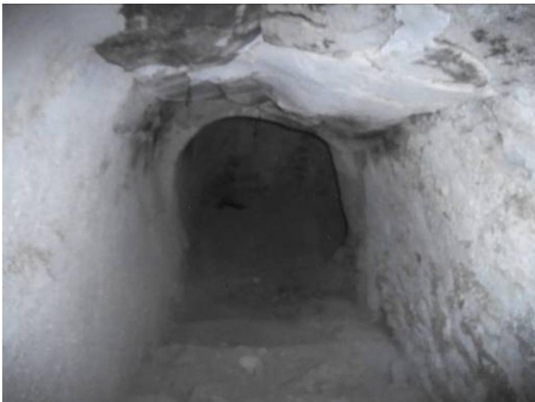
Con ancho de hasta 7 palmos (1,463 m), y continúa una galería plana de 6 palmos de ancho y 9 palmos de alto en su punto más elevado de bóveda apuntada, y a veces los hombros de la bóveda están conectados con piedras al muro central de 3 palmos de ancho (0,6269 m), siendo su altura en arranque de 1,45 m aproximadamente, y grueso de bóveda de 3 palmos (62 cm máximo).
