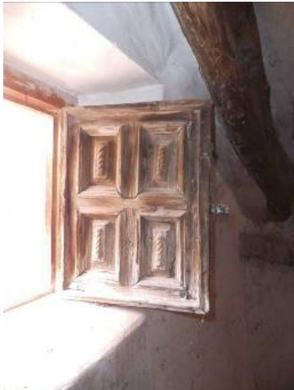
Las ventanas en general se colocan en el centro del muro de carga de 3 palmos de espesor. Tienen una sencilla cruz como protección, frente a posibles accesos, y no tienen cristal, solamente un ventanillo, de madera sin labrar, salvo la existente sobre comedor que ilumina las cámaras.
