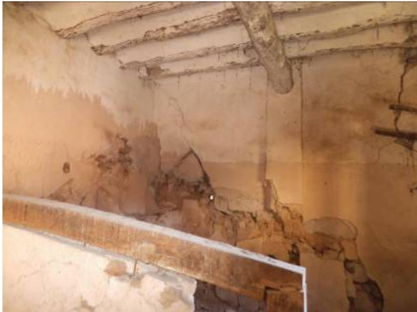
El forjado se realiza con rollizos apoyados en muros y en la actualidad están reforzados con viga en vano en sentido perpendicular y apoyado en machones realizados en paredes transversales, el muro transversal es más delgado, 15 cm y requiere de estos machones de piedra para apoyo de la viga o rollizo en este caso de diámetro 25 a 30 cm.
