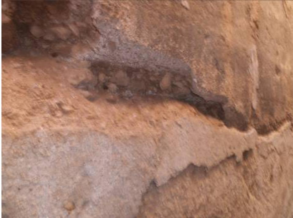
Corte de las tongadas de mortero de cal que forman el muro y revestimiento exterior.
