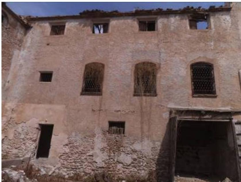
Los huecos de planta primera tienen 1,15 m de ancho por 1,94 m de altura libre hasta el arco rebajado de 19 cm deflecha. La formación del hueco presenta repisa realizada con tres hiladas de ladrillo macizo de tejar aplantillado, y la reja es artesanal a base de forja y uniones con remache y emplomados propios del Siglo XIX.
