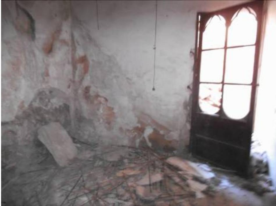
Dispone de pavimento sin separación del terreno, es un pavimento hidráulico, y el muro lateral norte al estar parcialmente enterrado, transmite las humedades procedentes de lluvias y del propio subsuelo, pues la cota del terreno está 1,00 m por encima del pavimento, se ha desprendido parte del techo y parte de revestimiento de los muros.
