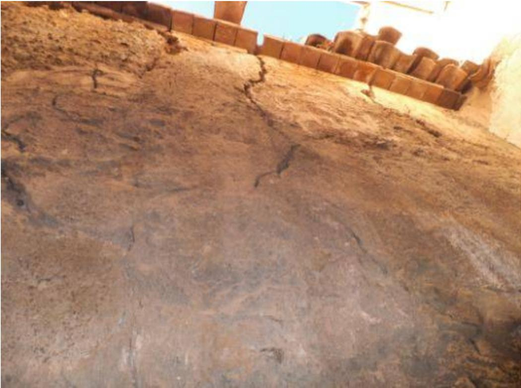
Muro norte derruido por acción del colapso de cubierta.
