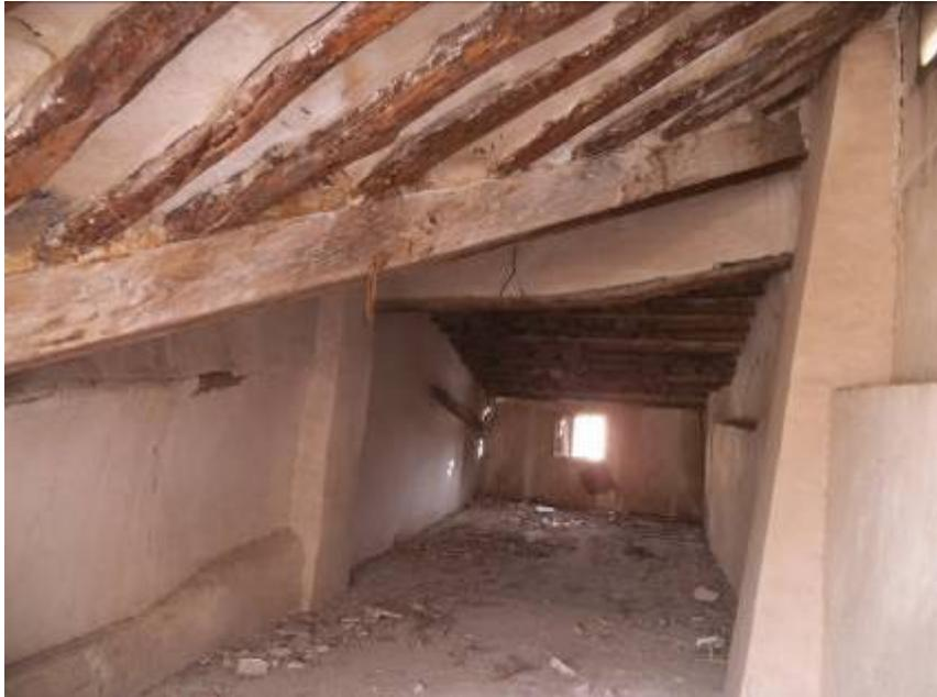
Este muro no se ve amenazado por estar bien sujeto con las maderas, y en su parte posterior a patio es la zona correspondiente a la ampliación que se hizo para aumentar la longitud de la bodega. La cubierta se desarrolla a lo moruno, es decir, las vigas apoyan en los muros como un forjado en horizontal, por lo que no hay empujes como cuando están inclinados formando la dirección de las canales y cobijas de cubierta.
