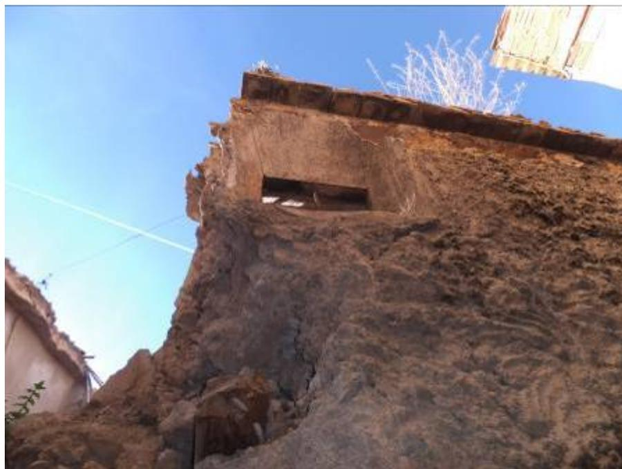
Estado de parte inferior del muro norte, se puede comprobar la línea de cal horizontal entre las tongadas de gravas y arenas de rambla que forman el muro calicastro, con revestimiento de argamasa de mortero bastardo.
