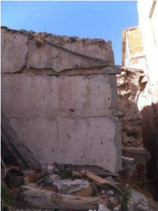
Pared de entramado de madera, relleno de cal y canto en cámaras de primera planta.
