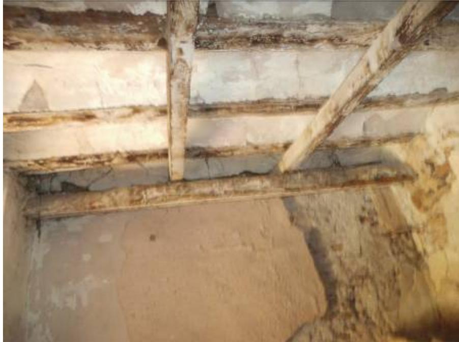
El entrevigado se realiza con revoltones o formación de bóveda sobre formero de cañón que se va sustentando entre las vigas y rellenando con mortero de cal y cascotes en dos pasadas, después se rellenan los senos junto a las vigas y se realiza una capa horizontal sobre la superficie plana que forman las vigas, y de esta forma se deja el pavimento listo para losar, o simplemente se cubre con capa de mortero de cal, con mayor dureza al desgaste.
