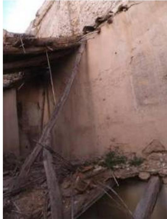
Acción del agua de lluvia sobre la estructura de madera que mantiene la propia cubierta.
