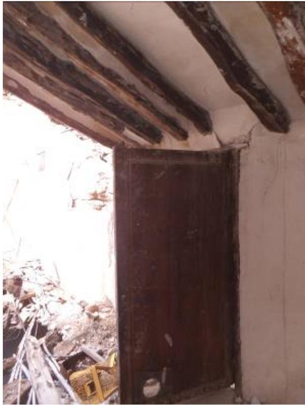
La cámara continúa la separación con otras que lindan con el patio renacentista, donde los rollizos se mantienen en buen estado, pues el tablero entre vigas está guarnecido con yeso y ha preservado más el paso del agua.
