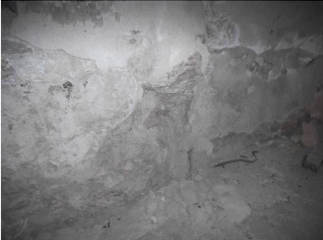
La ampliación de bóveda se aprecia mejor terminada y con mayor punto de curvatura, es por tanto menos rebajada y debería ser más resistente.
