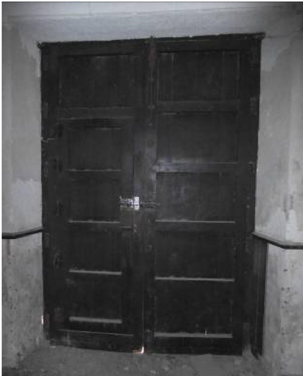
La puerta que es de madera está formada por dos hojas abatibles, y en la hoja derecha tiene un portillo de paso peatonal, el hueco de 1,67 x 2,50 m (2 varas de ancho por 3 varas de alto), tiene montantes y largueros de madera maciza y entablado clavado en la peinecería con sus refuerzos de chapa troquelada con decoración general y detrás.
